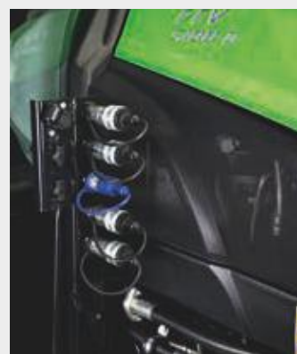
↑ Zainstalowane na środku przewody hydrauliczne do osprzętu montowanego z przodu.
